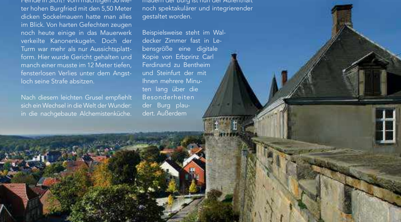
Brandneu: am 16. Juli wurde vor der Burg das neue Kassenhaus eingeweiht.
